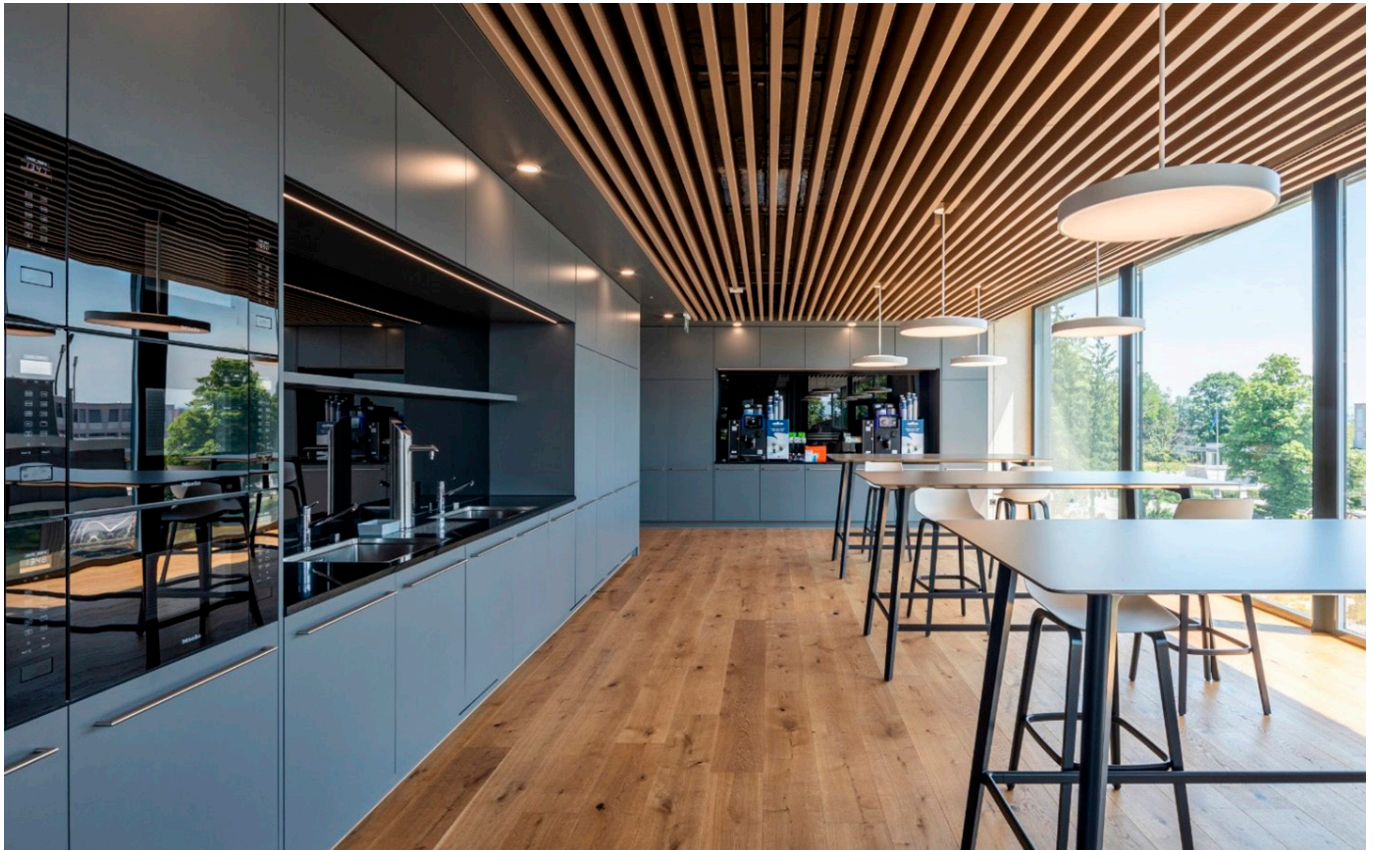
Abb. 10: Baffeln stellen eine geeignete Form von Deckenabsorbern dar. Im Bild handelt es sich um Heiz-/Kühl-Baffeln mit zusätzlicher Einlage von Schallabsorptionsmaterial (Akustikvlies und Mineralwollmatten).
