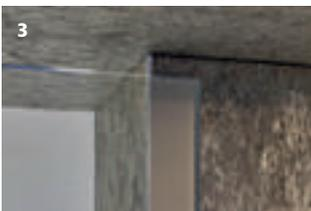
3 Auf die Vormauer geklebt mit Teillackierung
