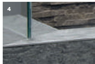
4 Eingelassen in die Nut mit UP-Profil Encastré dans le sol avec profil UP
