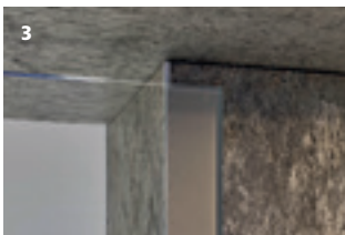
3 Auf die Vormauer geklebt mit Teillackierung Incollato su contromuro, parzialmente laccato
