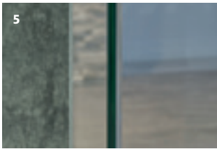
5 Verklebung Glas / Glas stumpf Incollaggio vetro / vetro senza bisellatura
