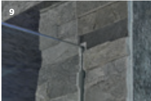
9 Ohne sichtbare Befestigung mit UP-Profil Senza elementi di fissaggio visibili con profilo a incasso
