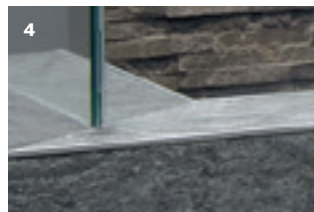
4 Eingelassen in die Nut mit UP-Profil Incasto nella scanatura con profilo incassato a muro
