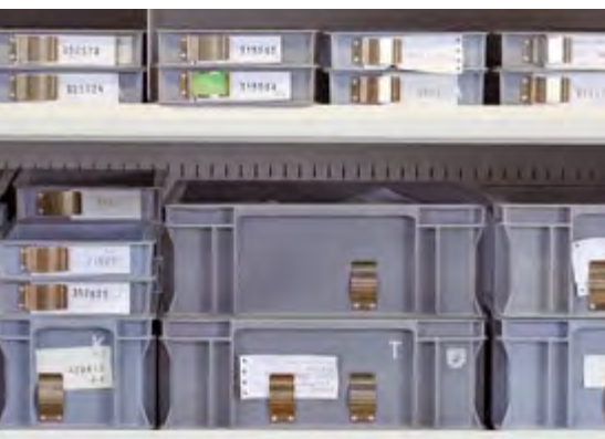
Zahlreiche Komponenten werden im Lagerlift in unterschiedlichsten Gebindegrößen übersichtlich organisiert
