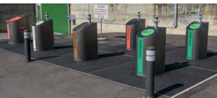
Systèmes de collecte enterrés pour les points de collecte de matières recyclables
