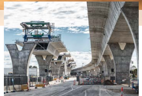
Hoch- und Tiefbau
