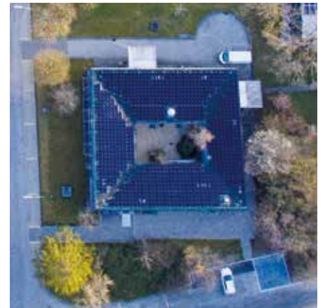
Produktionshalle mit Solardach
