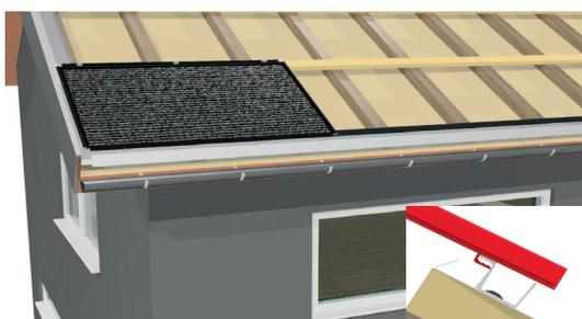
Nun beginnt die Montage: Der untere Spenglerabschluss wird als erstes befestigt, anschliessend wird die Basisschiene montiert und auf der Querlattung verschraubt.
